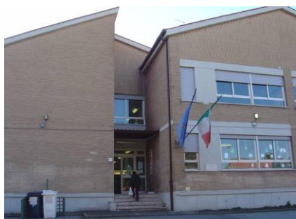
PLESSO "R. LA CROCIERA" Edificio di Via Egidio Garra 40
